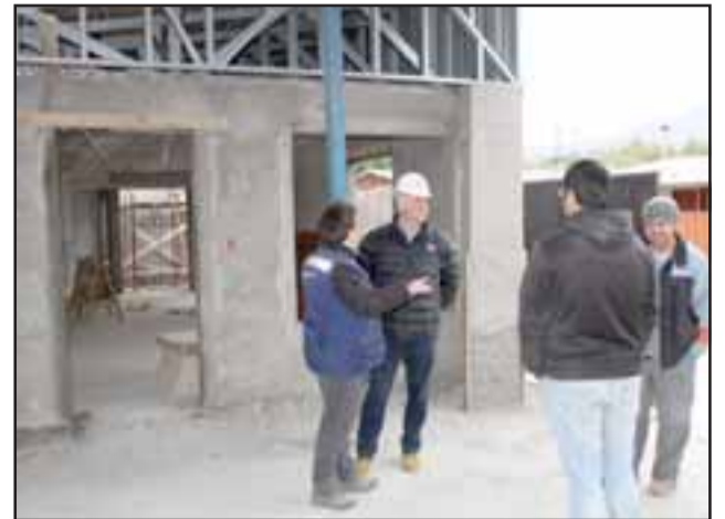
Los trabajos avanzan en un 70 por ciento de avance y el proyecto considera instalación eléctrica nueva, sistema de agua potable y alcantarillado.
