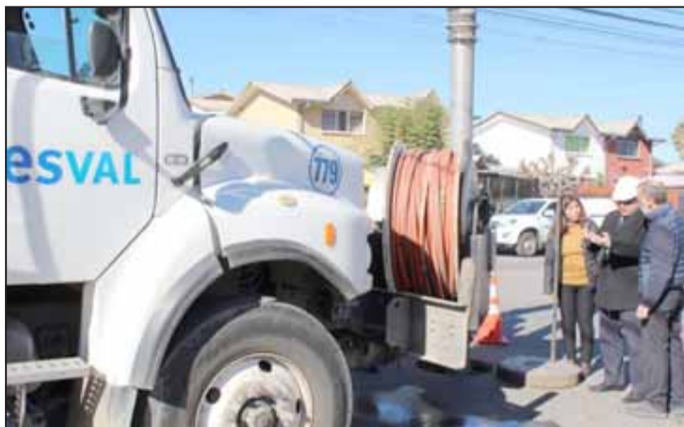
En los operativos, un camión jet mostró parte del mantenimiento preventivo, que consiste en succionar el caudal desde las cámaras de alcantarillado e introducir agua a alta presión para desobstruir el colector.
