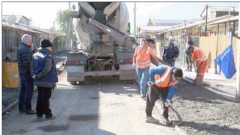
El alcalde Luis Pradenas en compañía de la directora de Obras Loreto Galdames, visitaron los trabajos que están en plena ejecución.
