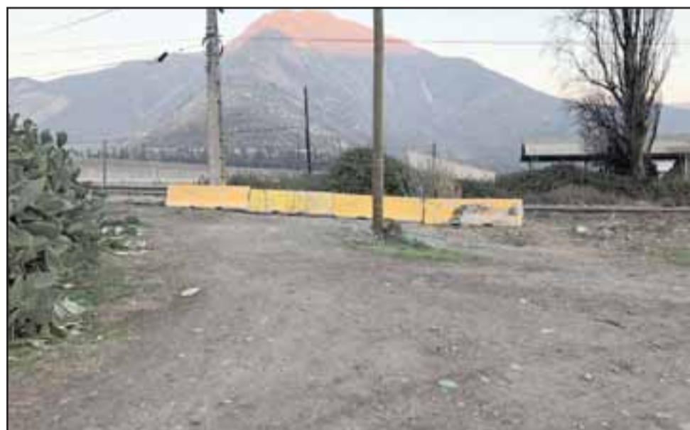
Tras acoger una solicitud de parte de los vecinos, se determinó la instalación de barreras tipo New Jersey.
