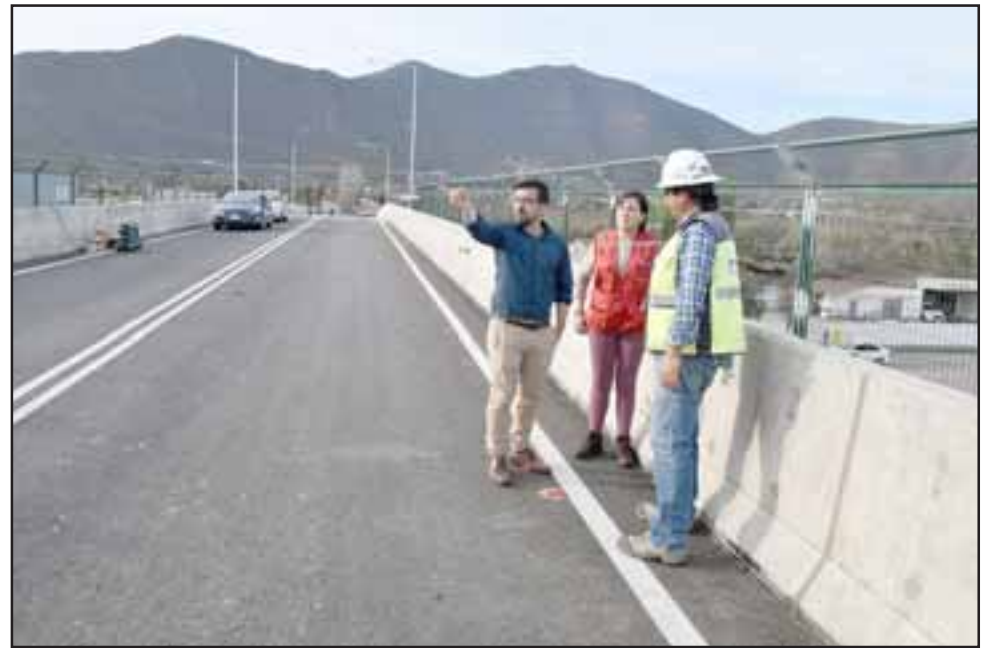
Tras 14 meses de intensos trabajos, el alcalde Edgardo González Arancibia, acompañado por Daniela Vargas, directora del Departamento de Obras Municipales y profesionales de la empresa Arrigoni, realizaron una visita inspectiva a este nuevo acceso.
