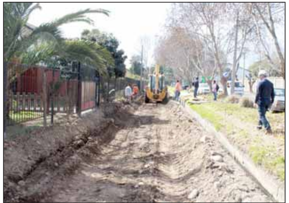
El alcalde Luis Pradenas realizó una visita a las obras de repavimentación del pasaje Troncal de la Villa Colunquén.
