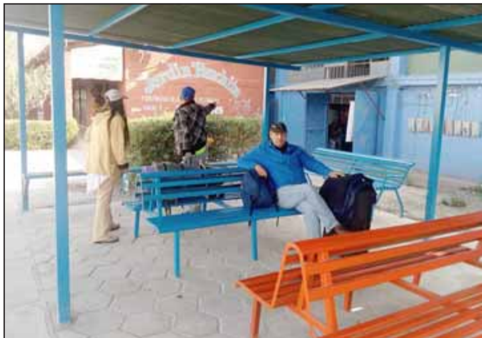
Los pasajeros del sector rural ya cuentan con un amplio y confortable paradero para protegerse de la lluvia o el sol.
