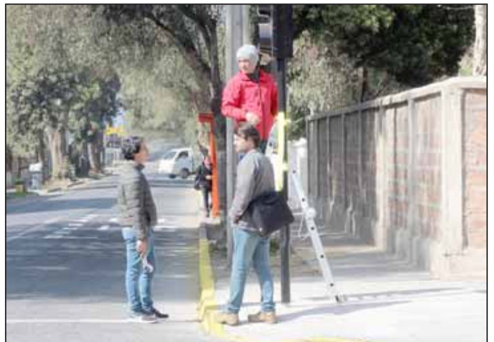
Técnicos realizando los últimos ajustes para el correcto funcionamiento del semáforo.
