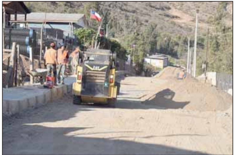
Los trabajos se ejecutan de acuerdo a los plazos establecidos, presentando un 50% de avance. Ya se construyeron las veredas y el muro de contención, y próximamente comienza el hormigonado.
