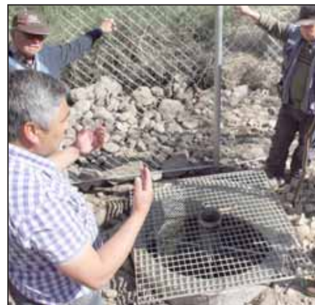
Las obras permitirán extraer agua desde una noria e impulsarla hasta estanques de almacenamiento, para luego ser distribuida a los hogares.
