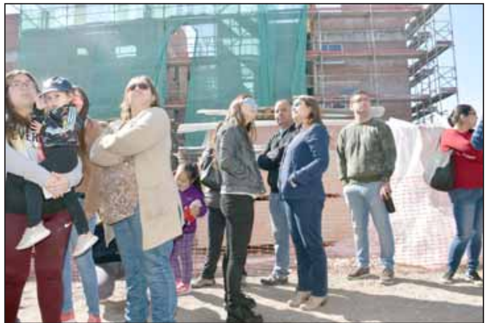
Los vecinos del comité pudieron ver el estado de avance de sus futuras viviendas.
