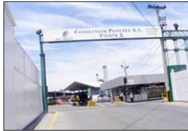
Frontis de la planta 2 Conserva Pentzke ubicado en avenida Manso de Velasco.
