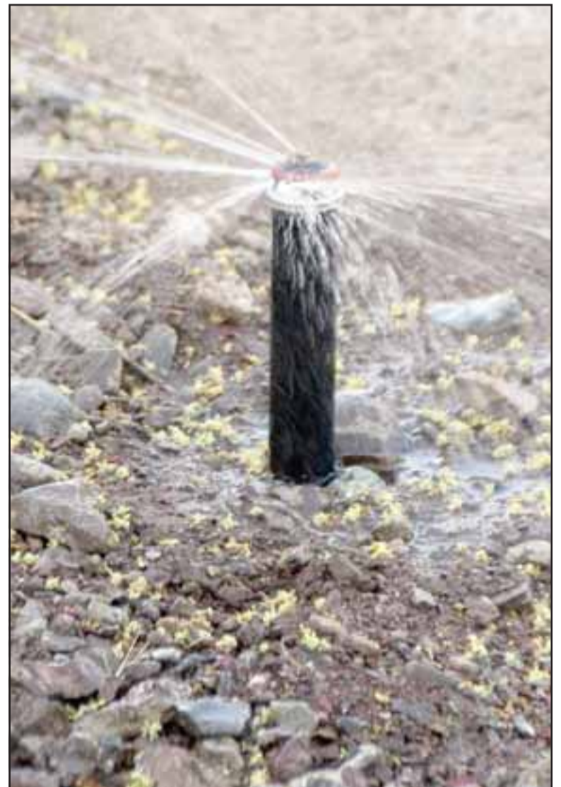
SON 18 DE ELLAS. - Esta es una de las 18 boquillas rotatorias de riego, las que refrescan permanentemente la plazoleta.
