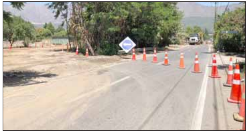
Con el fin de mitigar el impacto de los trabajos, se está habilitando un desvío en la ruta, el que está debidamente señalado y apoyado de banderero.
