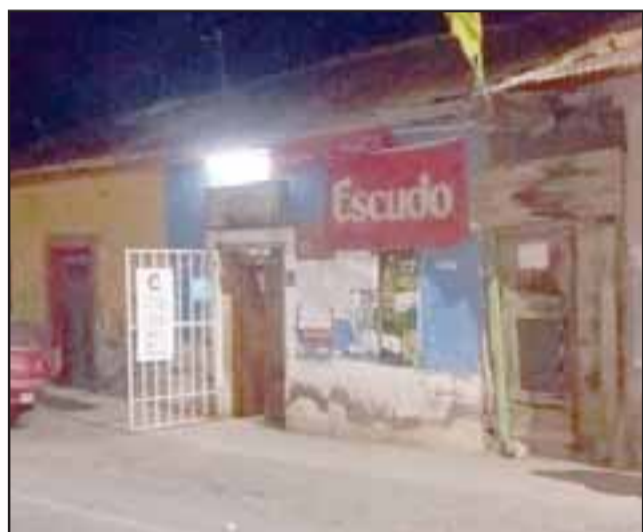
El minimarket afectado se ubica en calle San Fernando de la comuna de Santa María.
