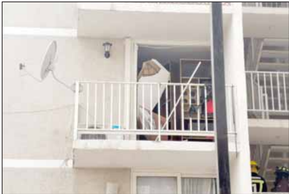
La explosión se originó en un departamento del tercer piso en el condominio Santo Domingo el pasado 25 de octubre de este año.
