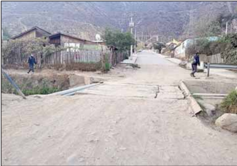
El proyecto incluye el remplazo total de los atraviesos existentes debido a su mal estado y serán reemplazados por una loza de hormigón con calzada vehicular y un pasillo peatonal.
