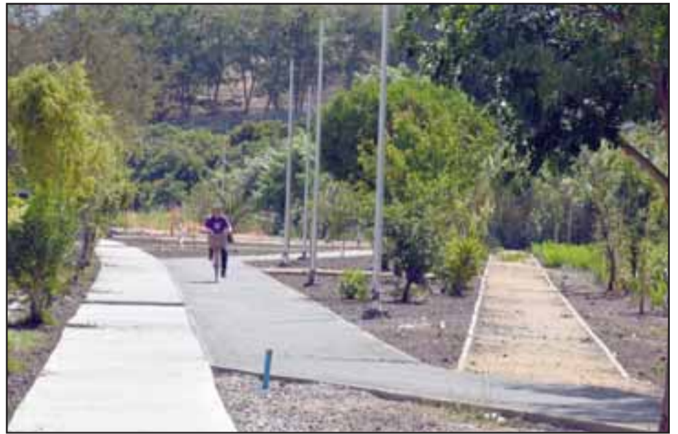
Las obras del nuevo parque presentan un gran avance y se espera que pueda estar terminado a inicios del segundo trimestre del año 2020.
