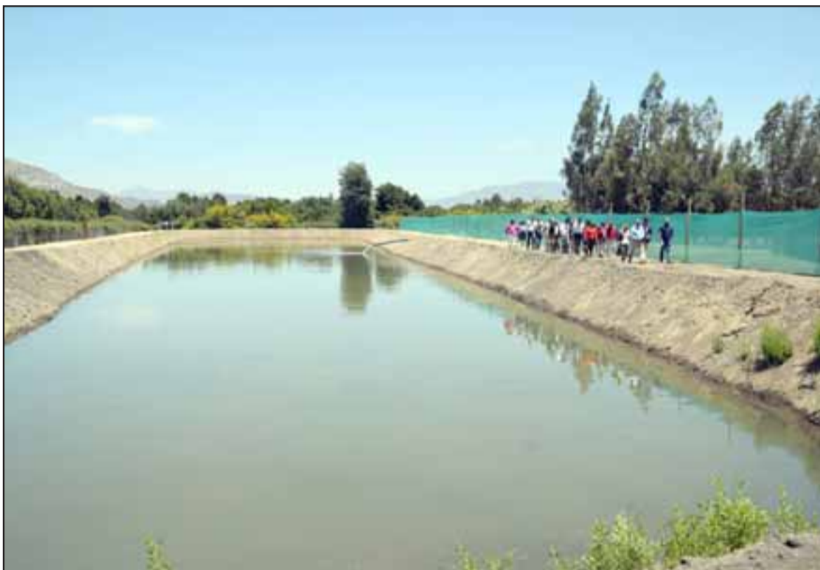
ENORME OBRA. - Este tranque que cuenta con una capacidad de 5.000 metros cúbicos, es llenado en dos días y medio por el Municipio que trata 2.000 metros cúbicos de aguas grises por día.
