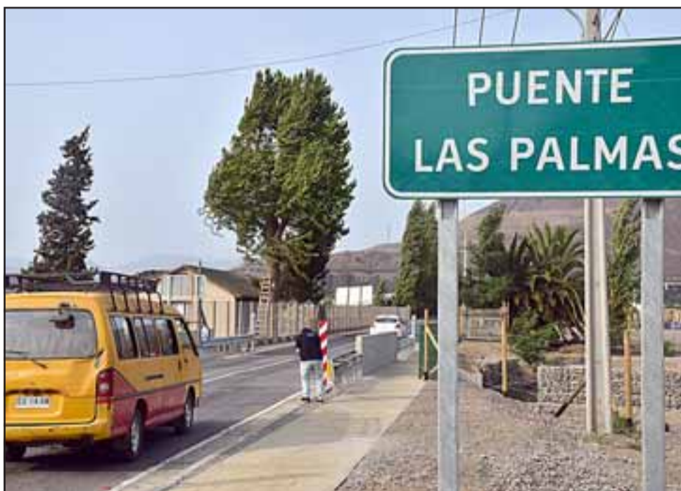
Estas dos obras significativas para el desarrollo de la comuna, como este puente, que viene a entregar mayor seguridad y conectividad para los vecinos de Las Palmas.
