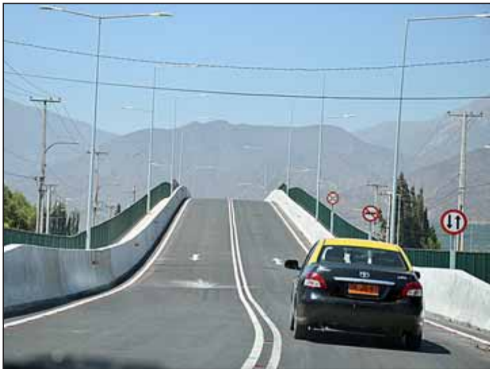
Después de un arduo trabajo ya se cuenta con estos viaductos, que da mayor seguridad a la comunidad en sus desplazamientos y un importante ahorro de tiempo.
