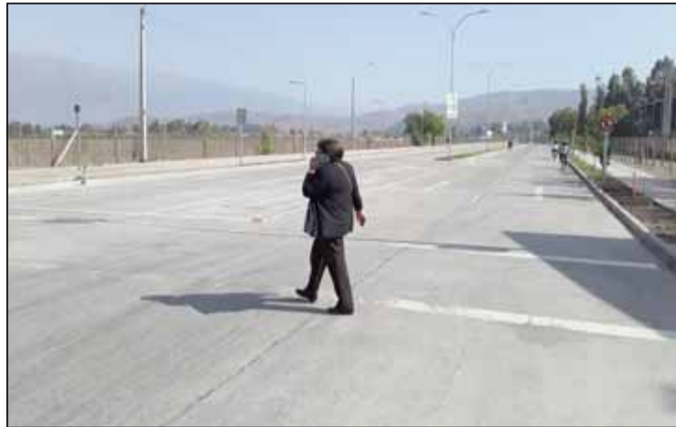
Esta es la Avenida Hermanos Carrera, entregada el día viernes, importante vía estructural que ha permitido dar conectividad vial a dos sectores densamente poblados.
