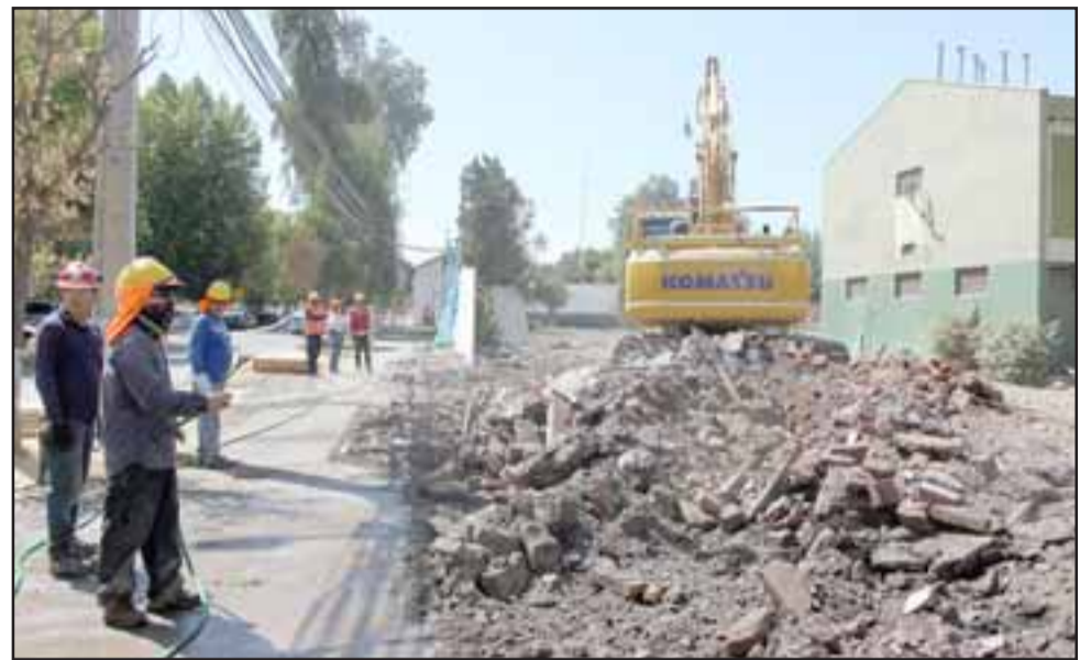
OBRAS AVANZAN.- Las cámaras de Diario El Trabajo registran los trabajos de demolición que desde enero se están ejecutando en el plantel policial.
