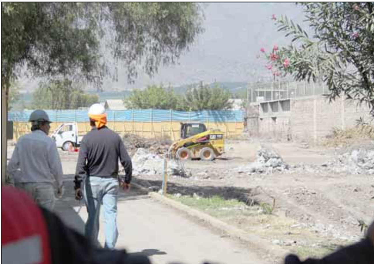
FUERON DEMOLIDAS.- Ya no existen las viejas instalaciones de la Segunda Comisaría de Carabineros, como lo registran nuestras cámaras ayer lunes.
