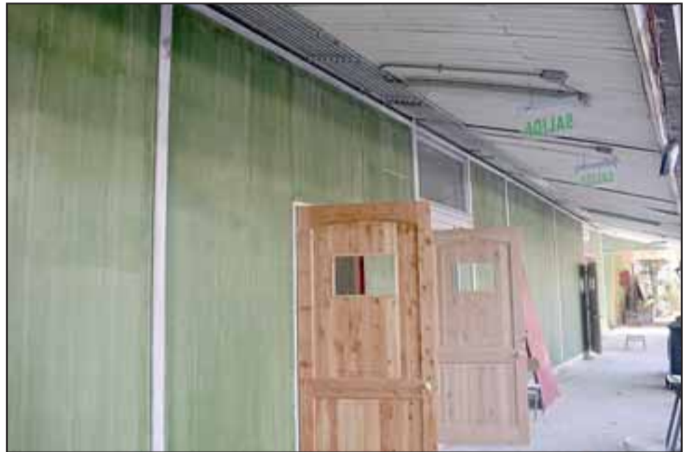
En Escuela Aurora Velasco del sector Las Cabras, el proyecto mejora tabique de salas de clases.
