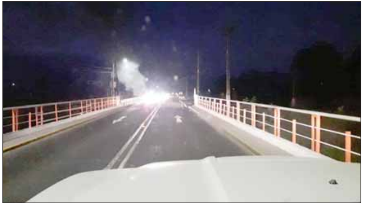
Al fondo del puente se aprecia el fuego que impedía el normal tránsito por el puente y que fue despejado por los propios automovilistas.
