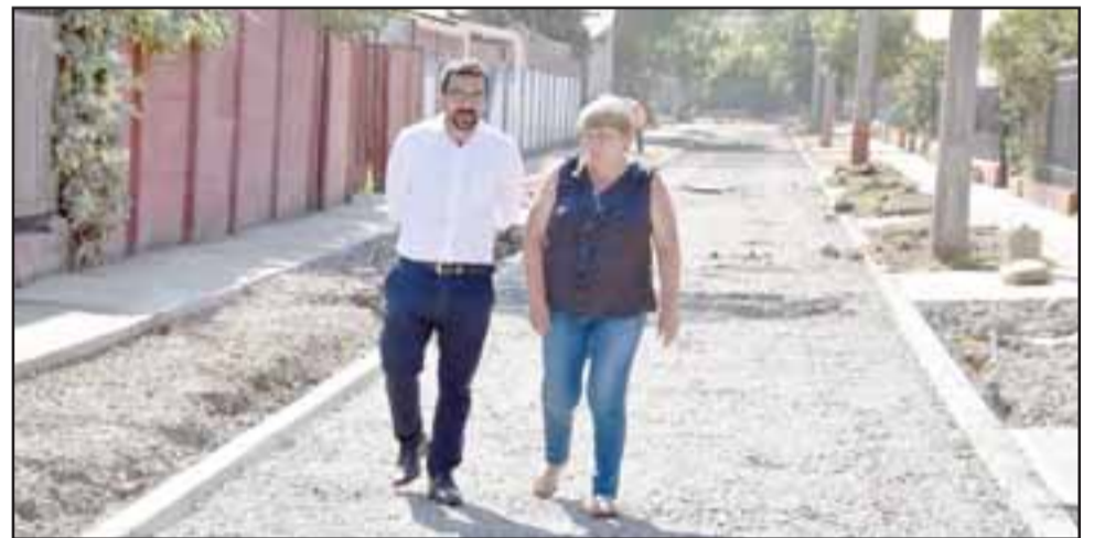
En plena ejecución se encuentra la construcción de pavimento y veredas en el Pasaje Lautaro de la Villa Llay Llay. En la imagen el alcalde Edgardo González recorre el pasaje junto una vecina.
