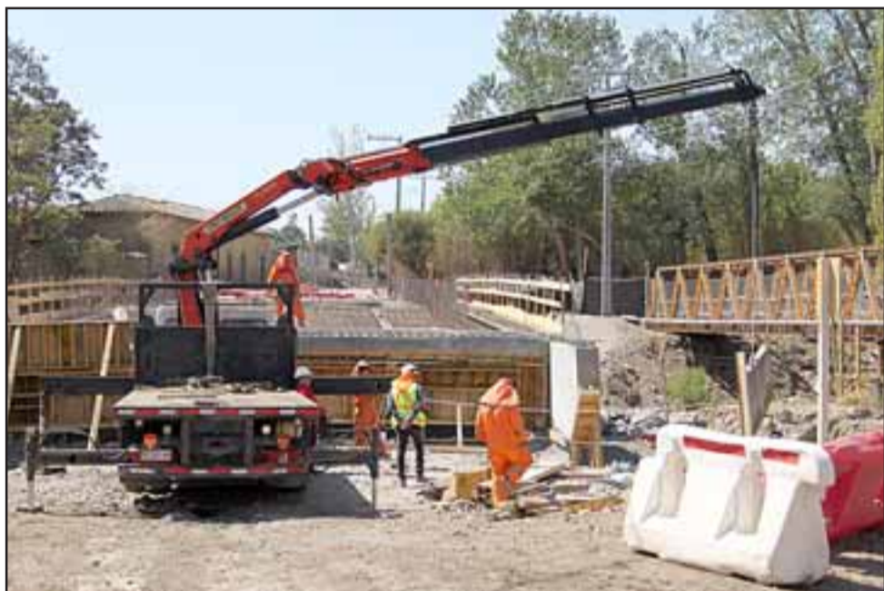
OBRA EN MARCHA.- Así luce el lugar donde finalmente quedará el nuevo puente.
