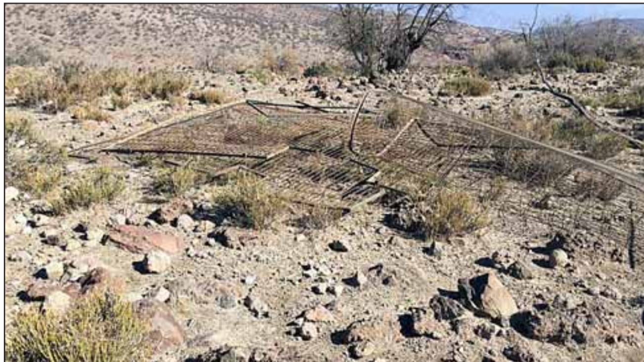
VALLA ARRANCADA.- La valla perimetral fue arrancada y tirada en las cercanías de la estación, los daños ascienden a más de un millón de pesos.
