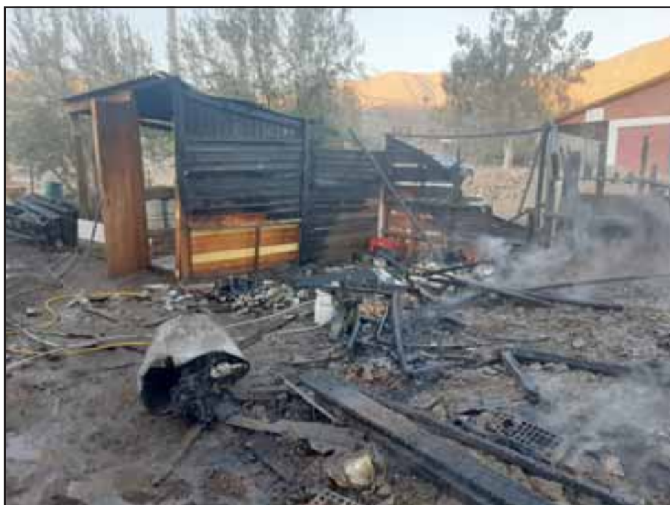
NADA SE PUDO HACER.- Pese al esfuerzo de los voluntarios de Bomberos para detener las llamas, el fuego finalmente destruyó por completo la bodega. (Foto gentileza de Emergencia Santa María)
