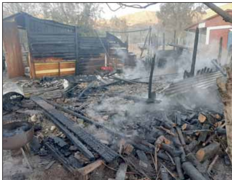
PÉRDIDAS TOTALES.- La dueña de la propiedad, una adulta mayor, sufrió una crisis de pánico tras ver en ruinas sus pertenencias. (Foto gentileza de Emergencia Santa María)
