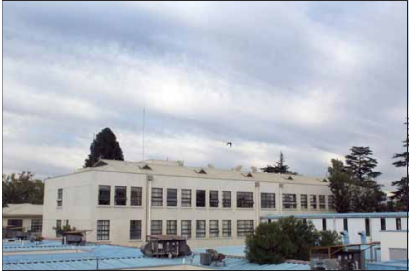
La UPC está ubicada en el tercer piso de hospitalización del recinto, donde antiguamente funcionaba el Servicio de Medicina.
