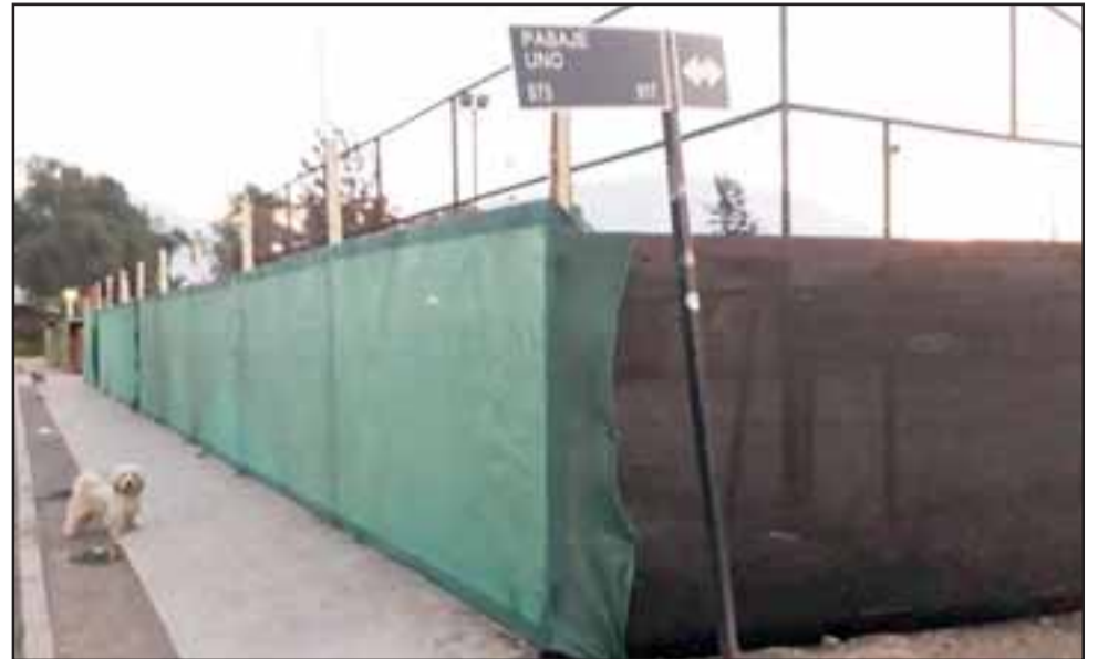
El terreno ya fue entregado para que la empresa a cargo inicie los trabajos en población La Escuadra.
