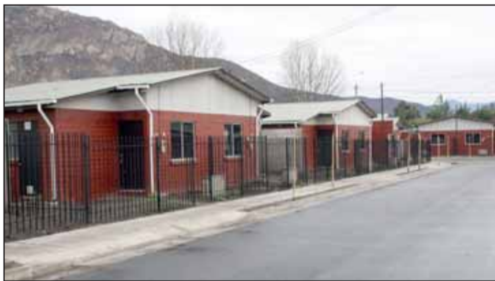
El conjunto habitacional comprende 42 viviendas sociales ya habilitadas para que sean ocupadas.
