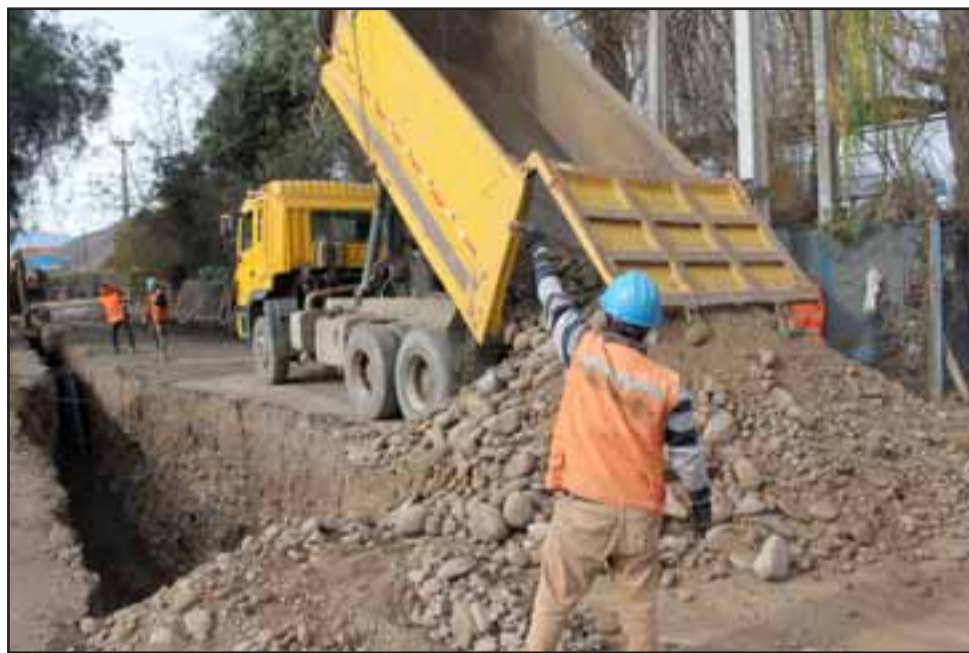
SIN PASO A LA TROYA.- Las cámaras de Diario El Trabajo registraron este jueves el accionar de la constructora que en estos momentos realiza los trabajos de excavación.
