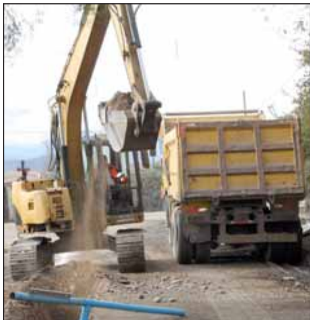
BUSCAR PASO ALTERNATIVO.- La maquinaria y las excavaciones ocupan la totalidad de la vía, no hay paso ni para residentes.
