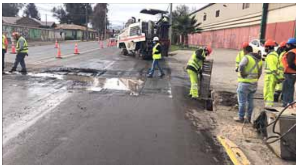
Este fin de semana Vialidad llevó a cabo trabajos en el sector de El Molino, donde se efectuó limpieza de ductos y el rebaje de la calzada, con el propósito de facilitar el escurrimiento de las aguas lluvia.
