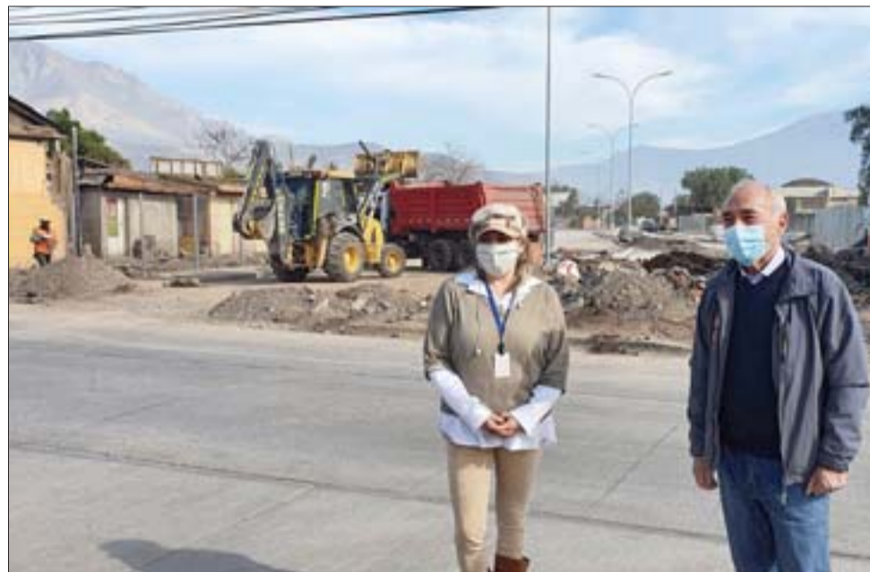
Hasta ahora se han habilitado los paños paulatinamente, si bien la obra no está entregada formalmente, el compromiso es que se pueda utilizar para el tránsito vehicular en septiembre.
