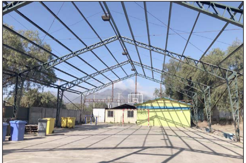
La Escuela 21 de Mayo en las primeras semanas de septiembre empezaría la obra, para techar esta estructura.
