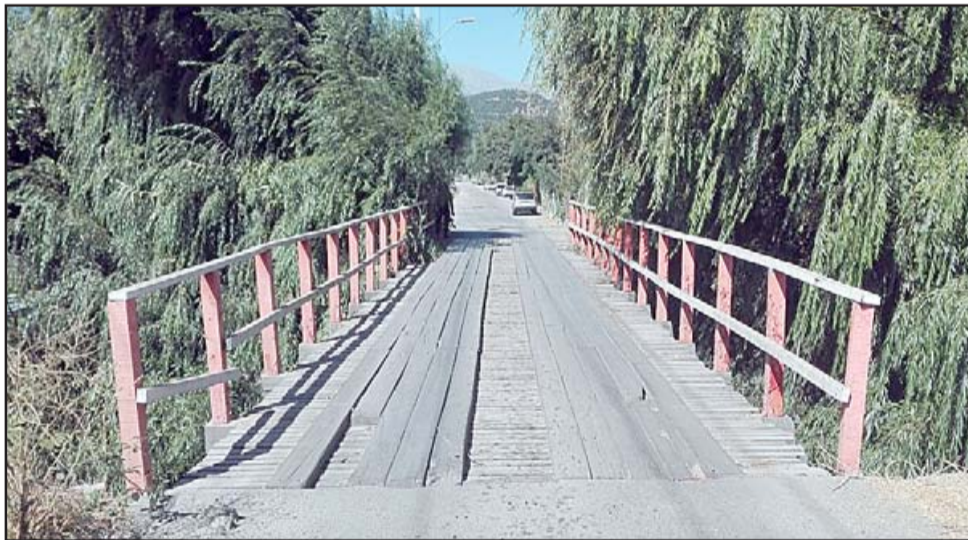
Más de 1.000 millones de pesos invertirá el Ministerio de Obras Públicas en los trabajos de reposición del puente El Molino, en la Ruta E-405, sector Las Vegas en la comuna de Llay Llay.
