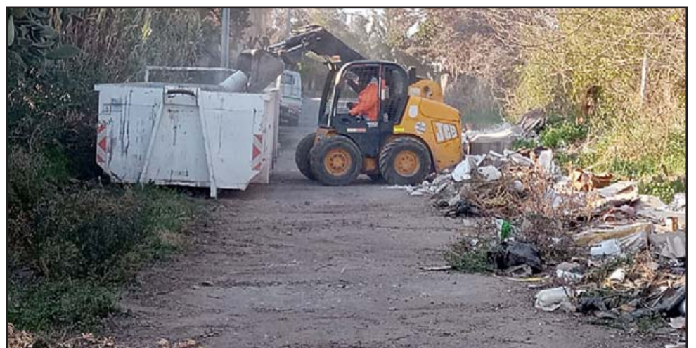
El gato hidráulico en plena operación de limpieza.
