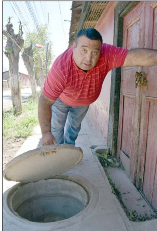
CÁMARAS TERMINADAS.- Lo bueno del caso, es que ya las cámaras de cada casa están terminadas, sólo falta que las obras sean certificadas y las entreguen a sus vecinos.
