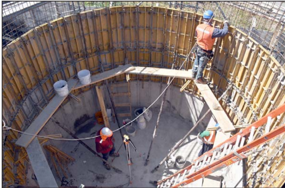
El proyecto consiste en construir una nueva torre de acumulación y regulación de agua potable, lo que triplica la capacidad de almacenamiento de agua.
