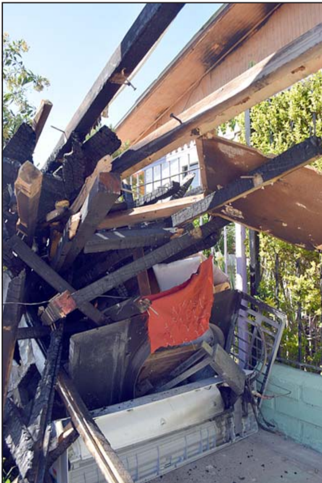
ARdua TAREA DE LIMPIEZA.- Grandes cantidades de escombros acopiados es lo que han sacado los voluntarios de lo que queda de estas viviendas.
