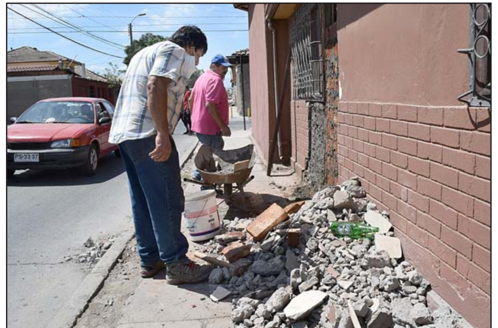
MANOS A LA OBRA. - La mañana de este martes don Cristian y otro vecino trabajaban arduamente para reparar los daños causados.
