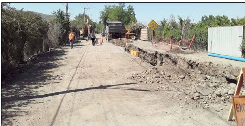
Personal efectuando trabajos.
