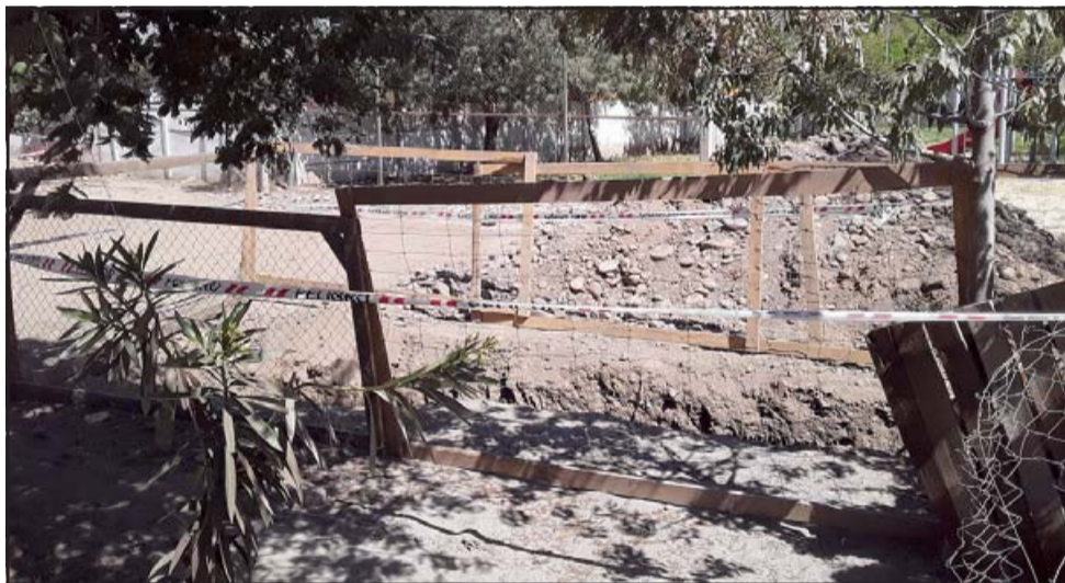
En este lugar estaba construida una cancha de tenis, al fondo casas que quedaron literalmente encerradas por las obras.
