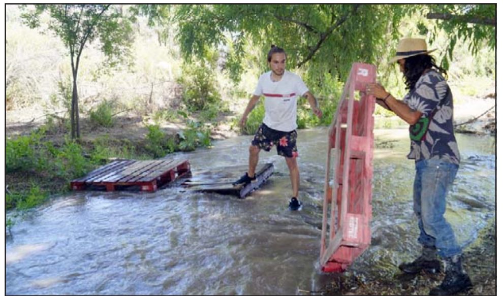
YA EN MARCHA. - Ya se están momentáneamente habilitando puentes para poder transitar e ir preparando el terreno como corresponde.
