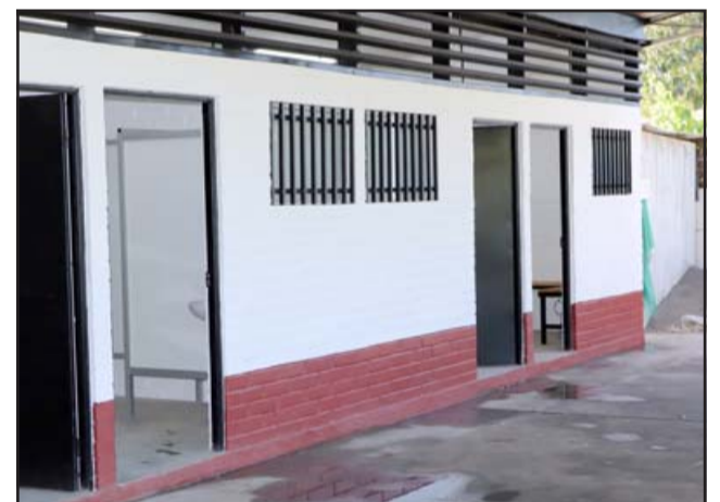
Los trabajos consistieron en construcción de baños, camarines, salón de reuniones y cierre perimetral de la cancha.
