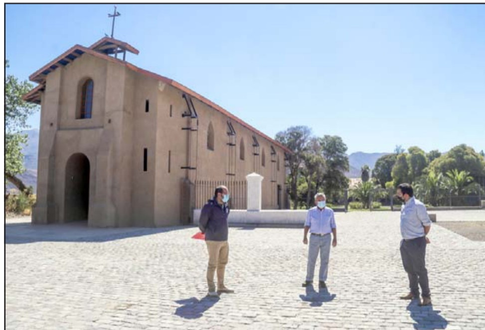
Así luce hoy día la Capilla Lo Vicuña, no obstante aún quedan obras por realizar.
