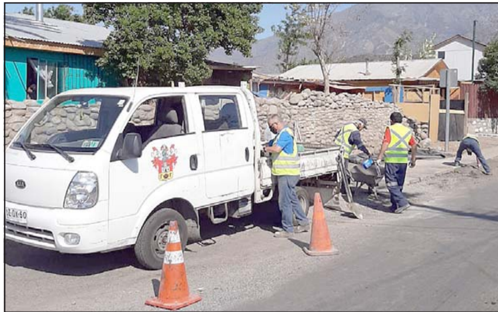
El Concejo Municipal aprobó por cuatro votos a favor y dos en contra, la contratación de mano obra local y especializada en albañilería, gasfitería, carpintería y electricidad para formar una cuadrilla municipal de trabajo en terreno.
