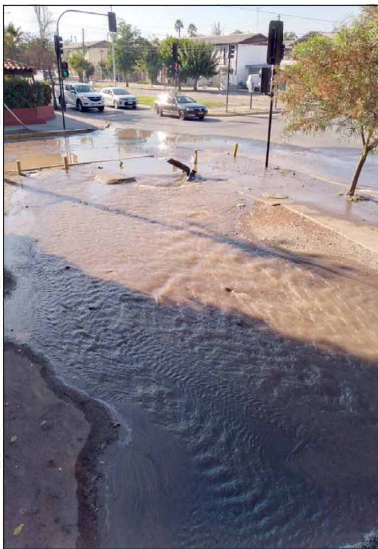
Este es el punto exacto donde se produjo la rotura de la matriz de agua potable.
