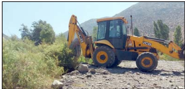
Maquinaria Municipal estuvo interviniendo el punto de captación del APR Los Patos.
