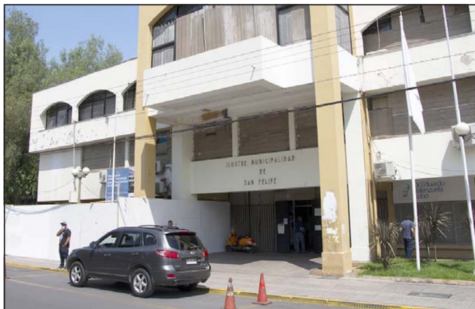
Las obras consisten en recambio de vidrios, pintura de fachada y recuperación del espacio que resultó dañado en el primer piso tras el estallido social, el cual permitirá trasladar las dependencias de Rentas y Tesorería.
