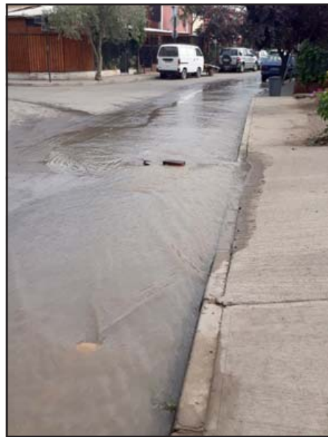
Este es el sifón que provocó la inundación de los pasajes 3 y 4, además de algunas viviendas en la Villa Curimón.
