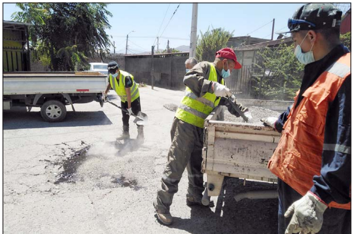
ARRANCARON BIEN.- Las cámaras de Diario El Trabajo registran el momento en que iniciaron las obras en el pasaje JL Castro en Población Aconcagua.
