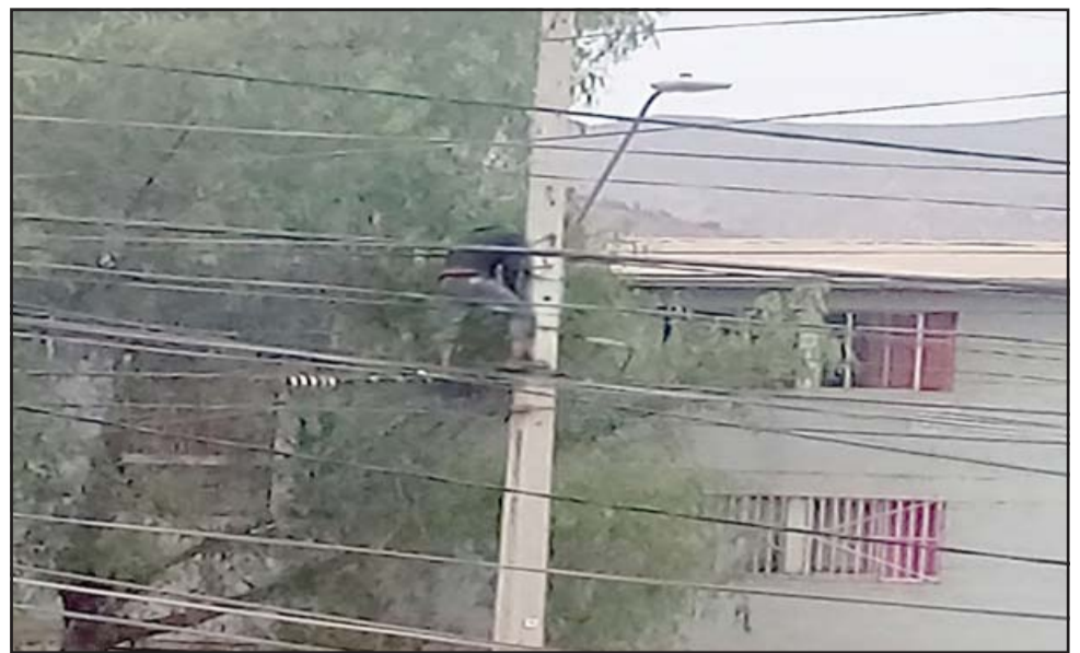
Acá se aprecia al sujeto arriba del poste efectuando las conexiones.
