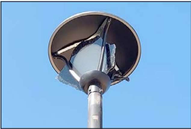
No solo el robo ha afectado a los vecinos, también la destrucción sin sentido del vandalismo inconsciente.
