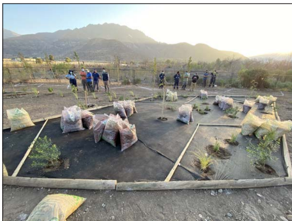
El alcalde Christian Beals visitó los trabajos que se están desarrollando en dicho sector, uno de los más abandonados de San Felipe, y destacó la importancia que estas intervenciones tienen en la calidad de vida de los vecinos.
